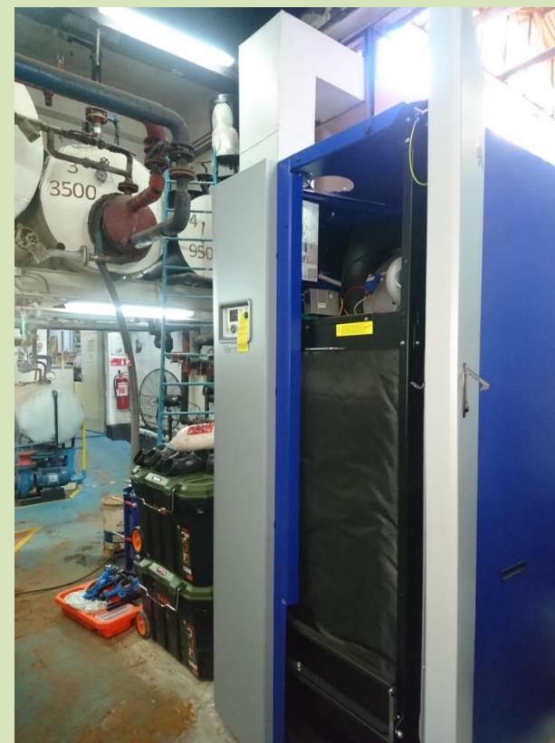
Instalación nueva caldera
